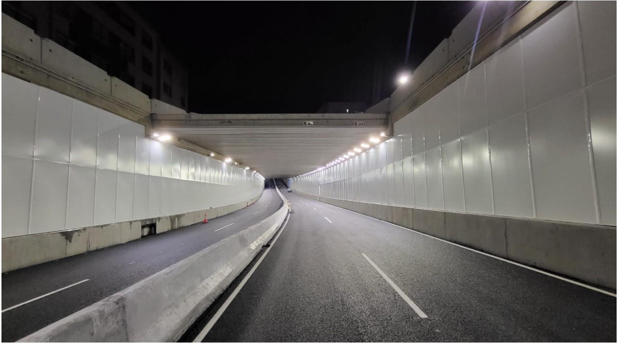
Nuevo paso inferior
