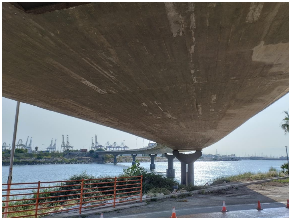
Acceso Puerto València V-30 p.k.0
