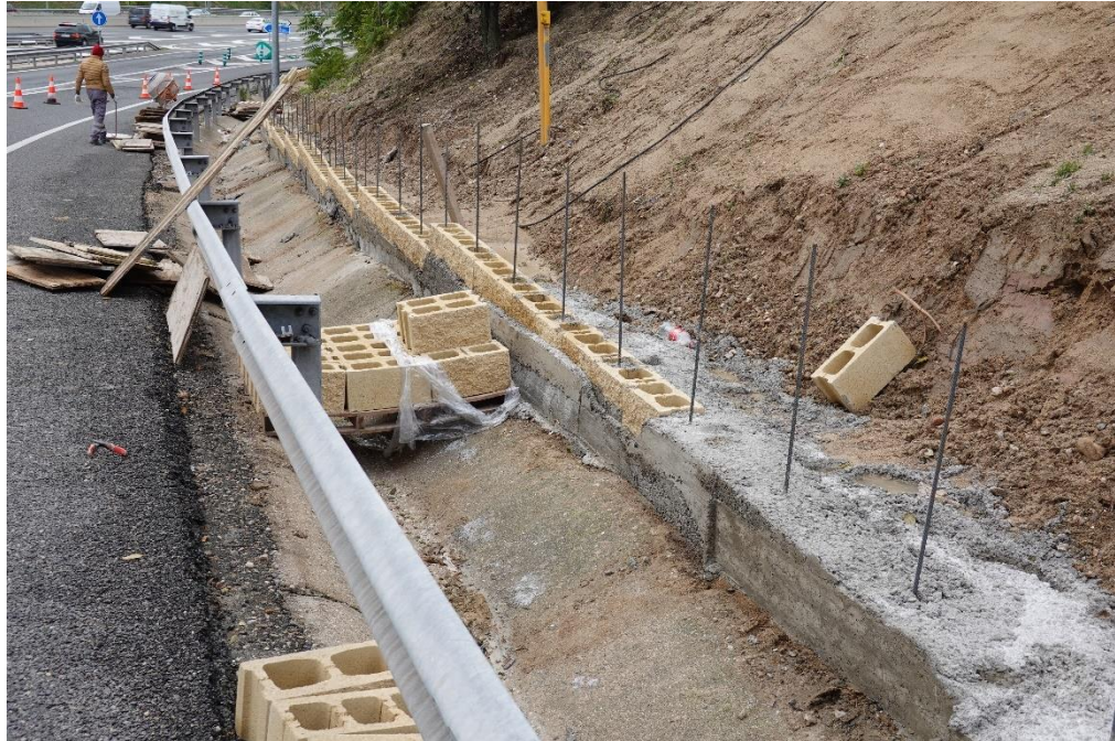
Protección de taludes
