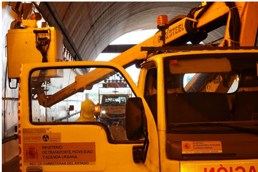
Mantenimiento de túneles El Pardo
