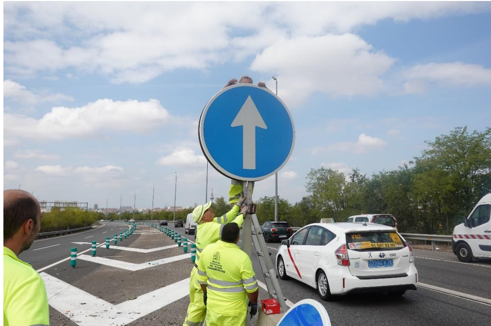
Sustitución de señales
