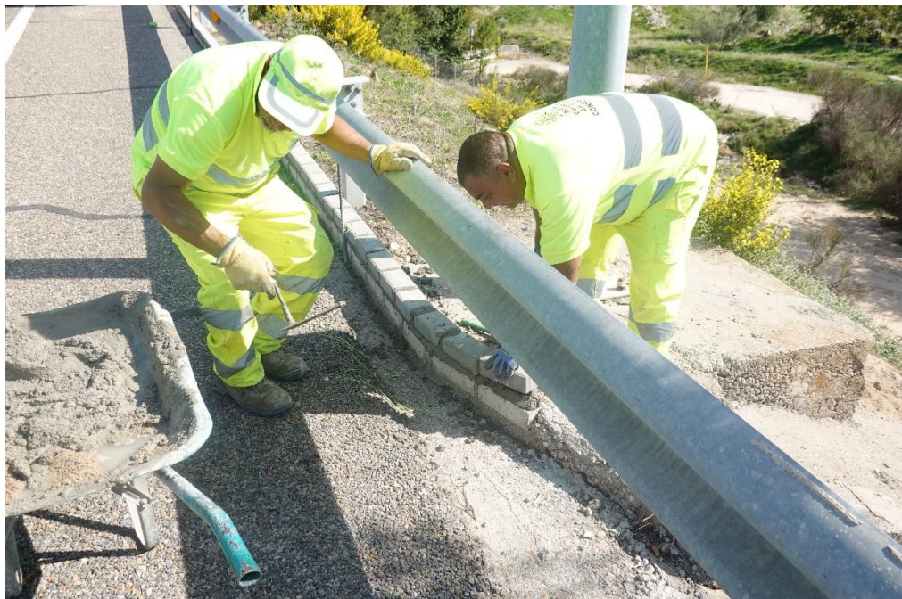
Reparación de bajantes
