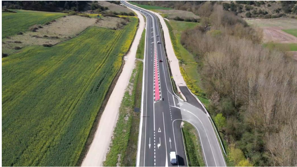
Tramo 2+1 desde los túneles de Ezcaba hasta Olave ya ejecutado de la carretera N-121-A.
