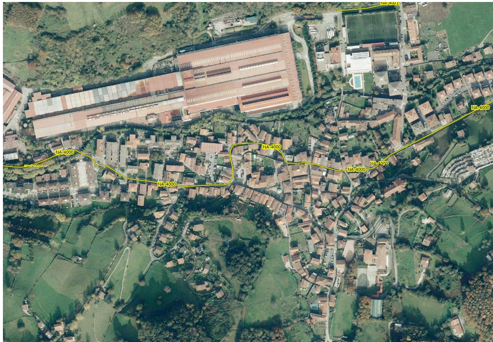
Situación actual de la travesía de Lesaka (Navarra)
