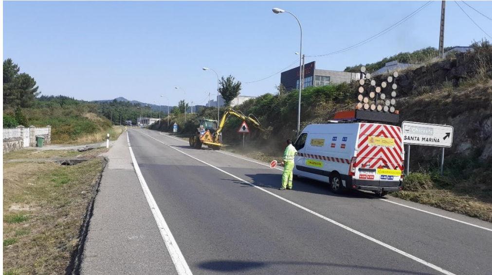
Desbroce N-525 PK 216
