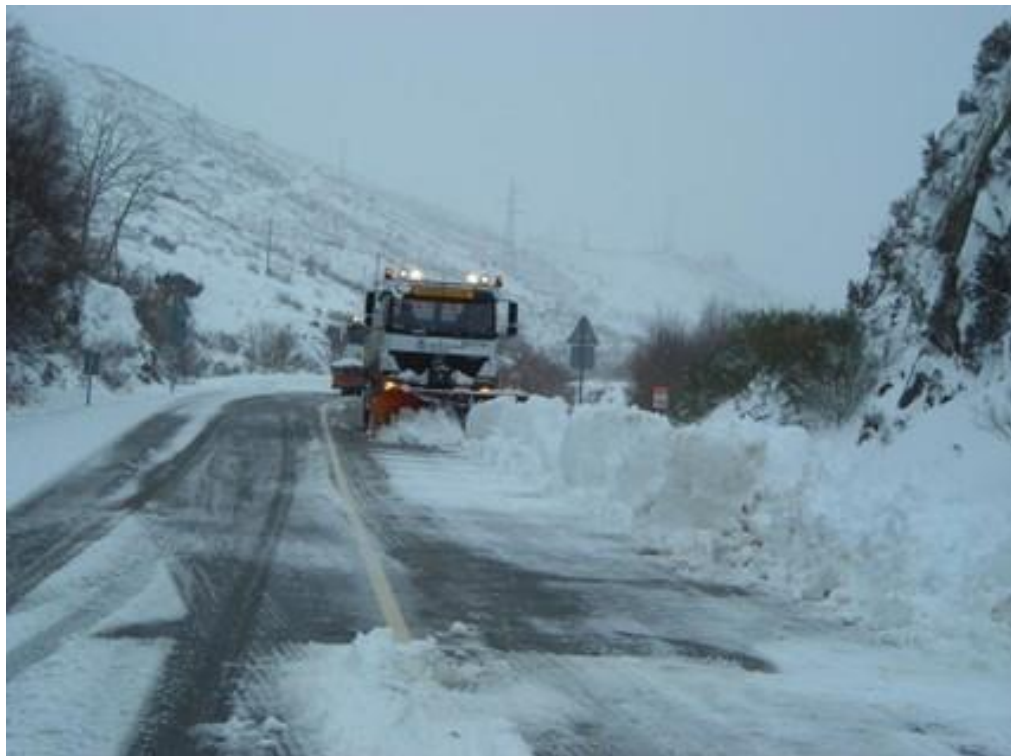
Retirada de nieve N-525 PK 116
