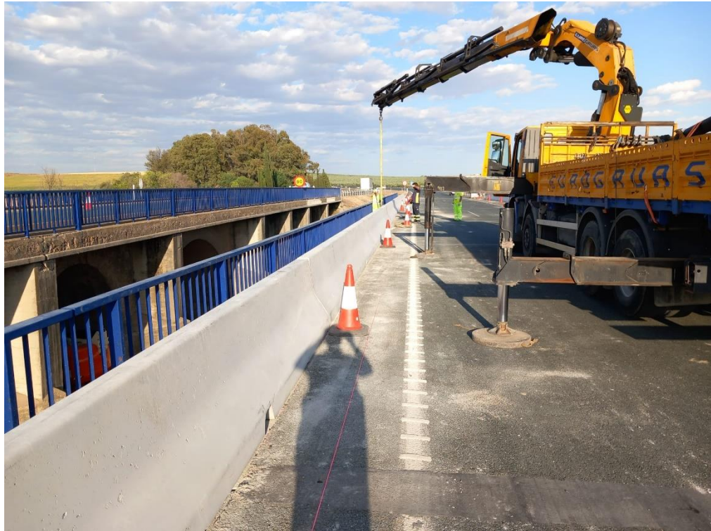
Colocación de barrera New Jersey en el p.k. 473 de la A-4
