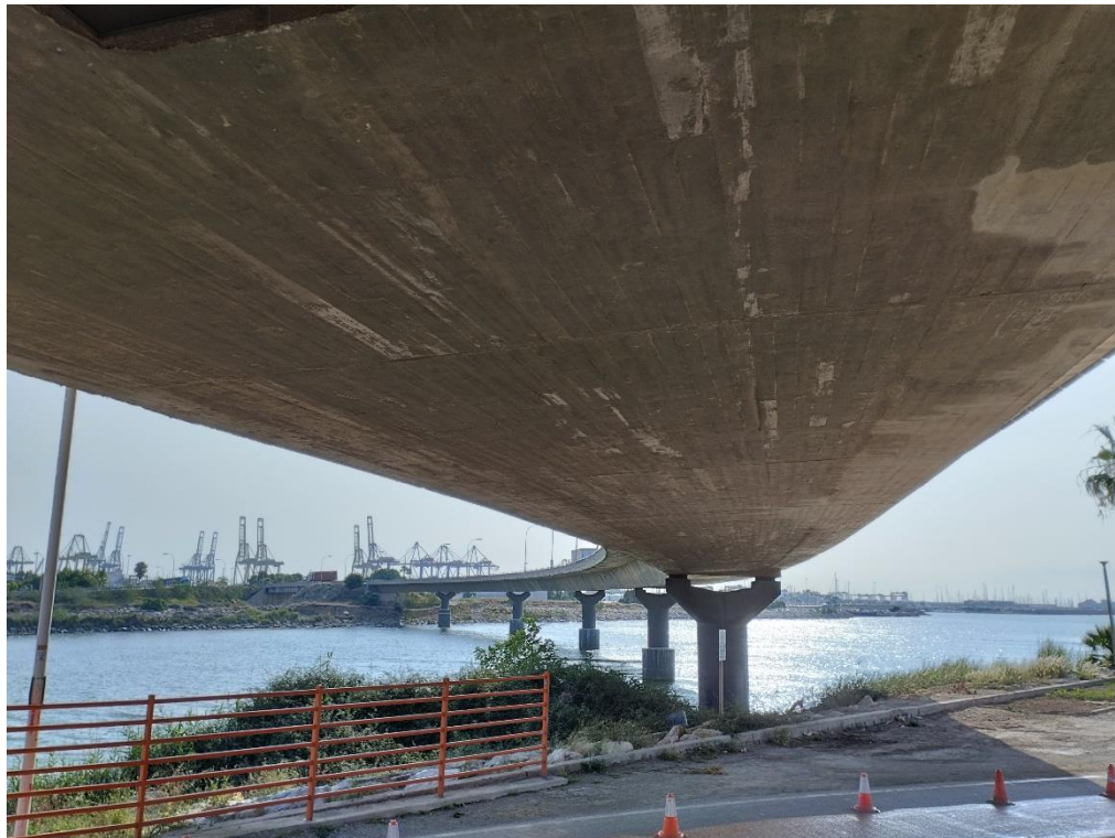
Acceso Puerto València V-30 p.k.0
