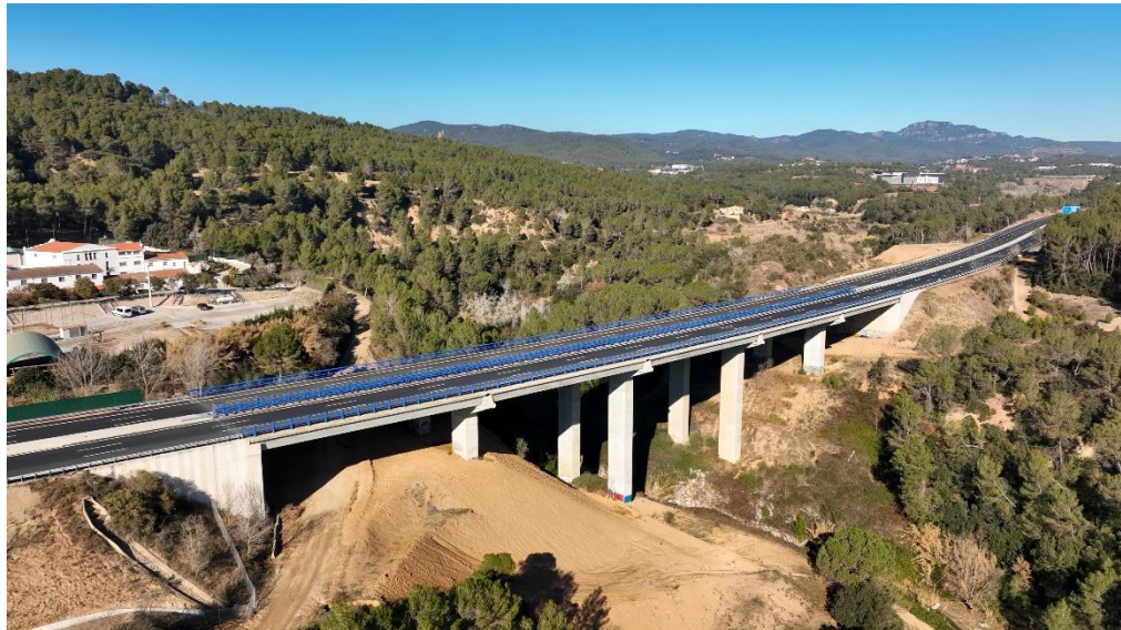
Viaducto sobre Riera de Gaià
