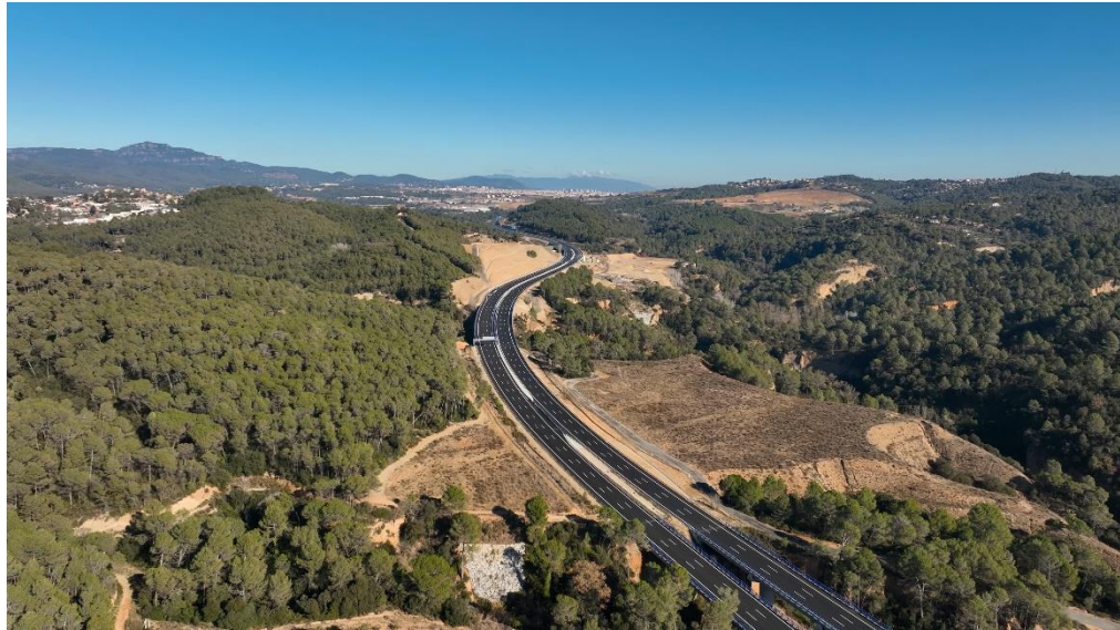
Vista general B-40 en sentido Viladecavalls
