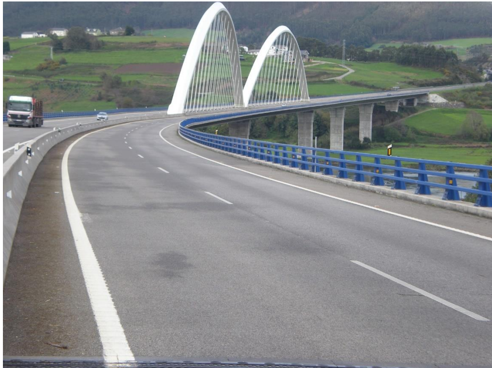
Viaductos ríos Anleo y Navia km 479,313, A-8
