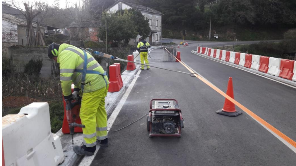
Instalación pretil Puente del Esquilo km 0,340 N-640A
