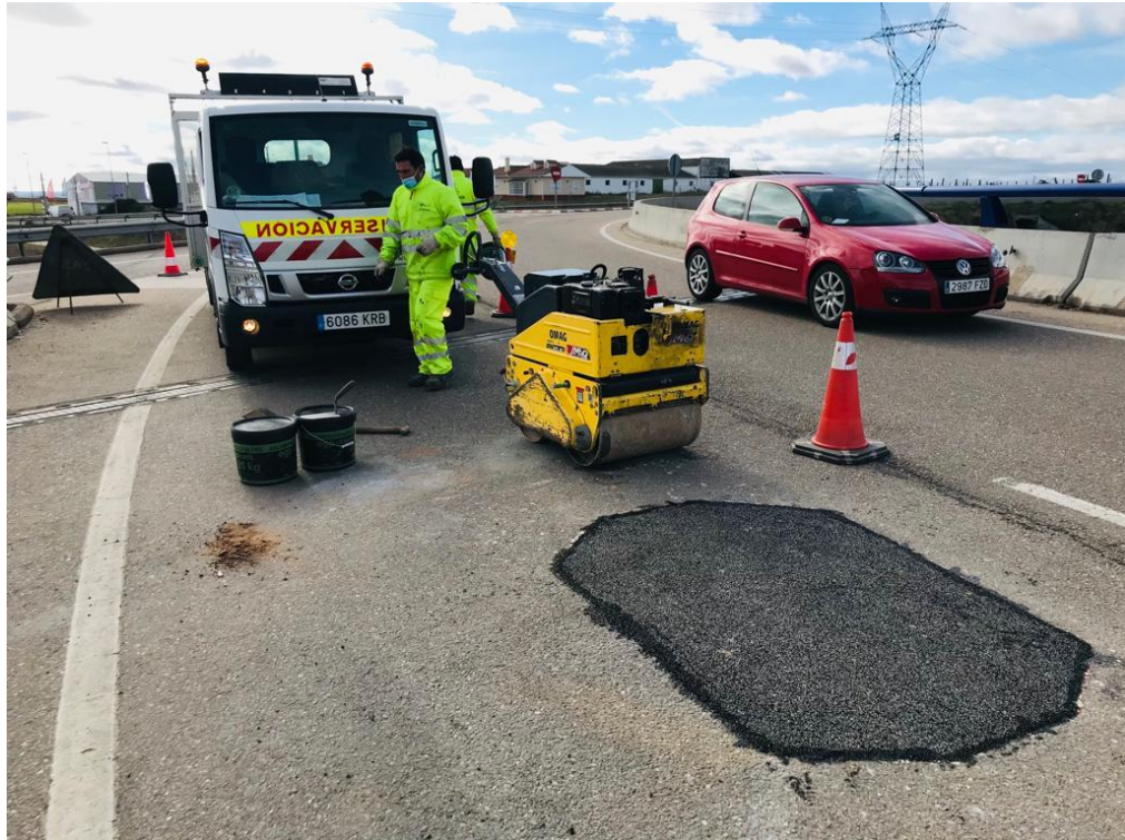
Parqueo A-11 PK 463+250
