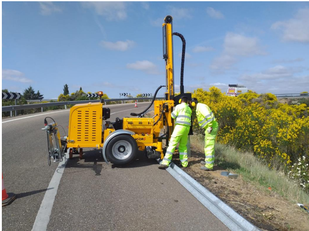
Colocación barrera seguridad ZA-13 PK 2+000
