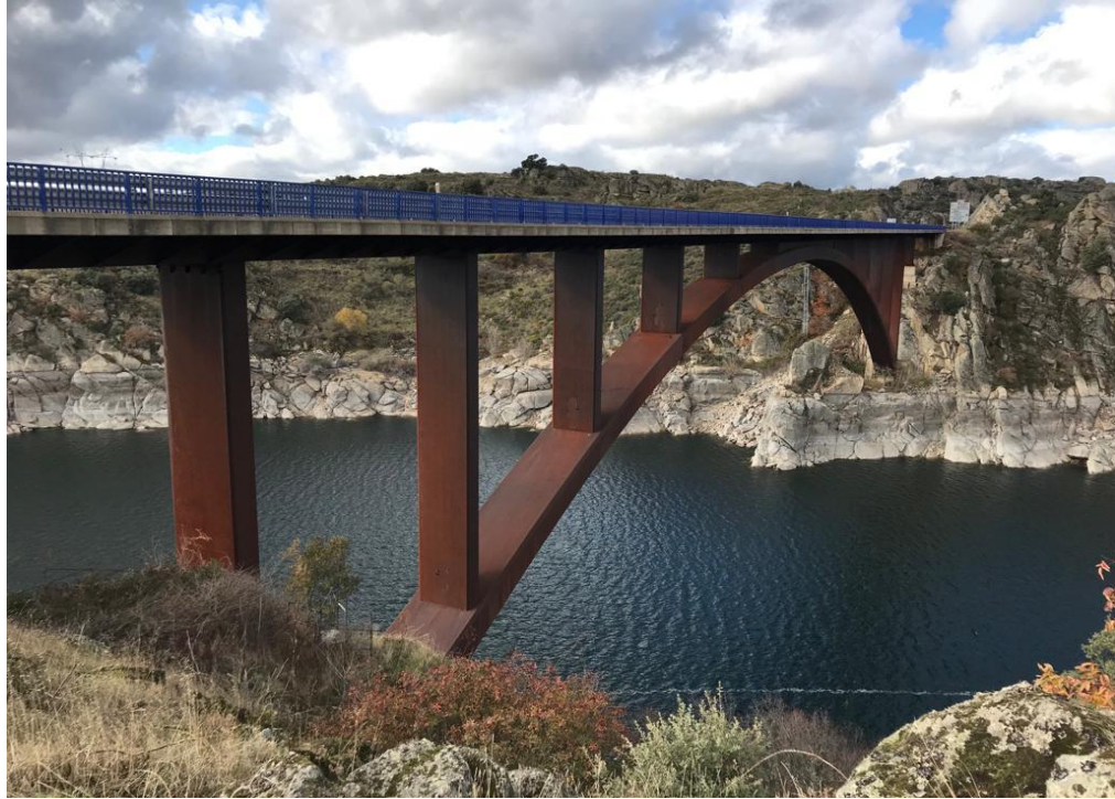
Viaducto sobre embalse de Ricobayo N-122 PK 480+150
