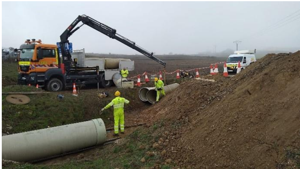
Reparación de ODT en el km 30,050 de la A-5
