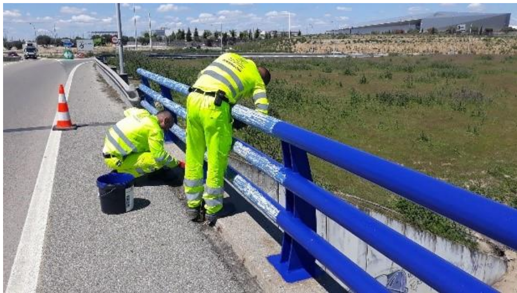
Repintado de barandillas en el km 21,300 de la A-42
