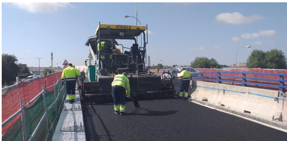
Asfaltado del tablero de km 19,600 de la A-42
