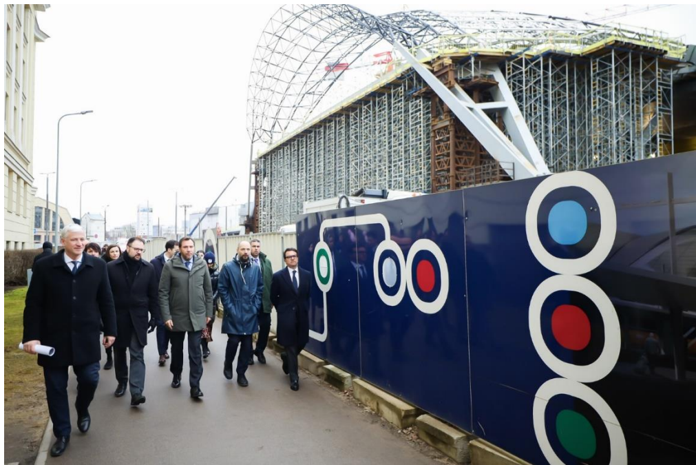
Visita a las obras de la cubierta de la estación de Riga.
