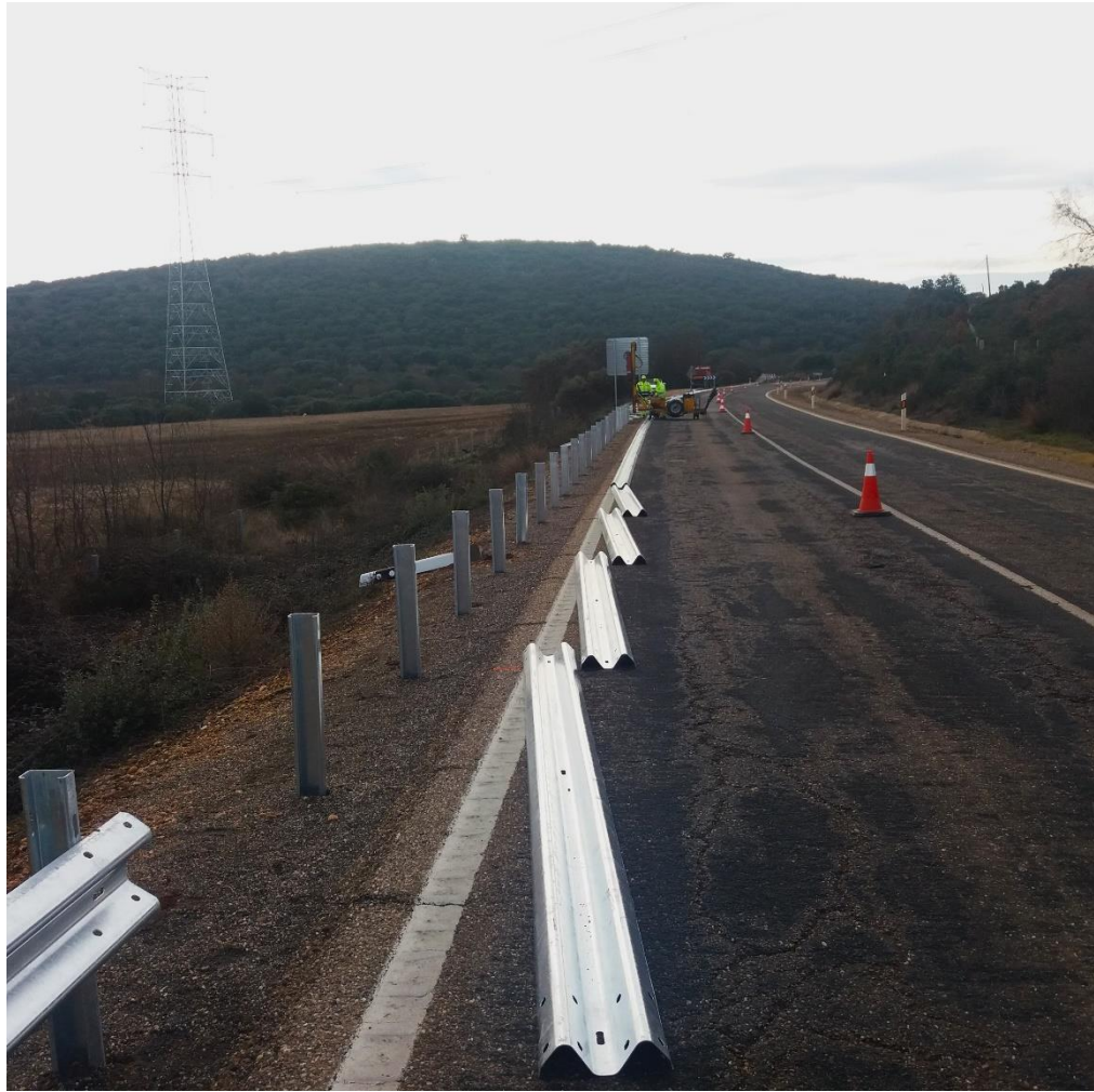
N-631 km 10,415 MD Colocación de barrera
