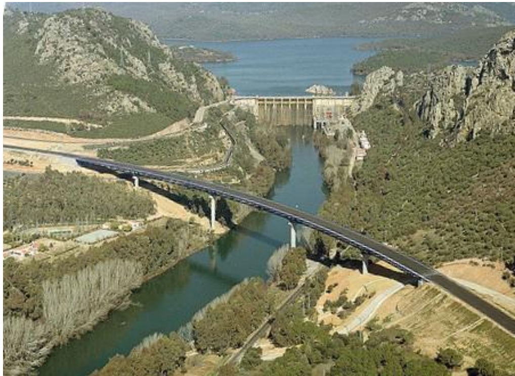
N-430, km 168. Viaducto sobre el río Guadiana. Vista aérea.
