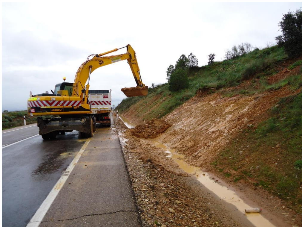
Retirada desprendimientos. N-430, km 112
