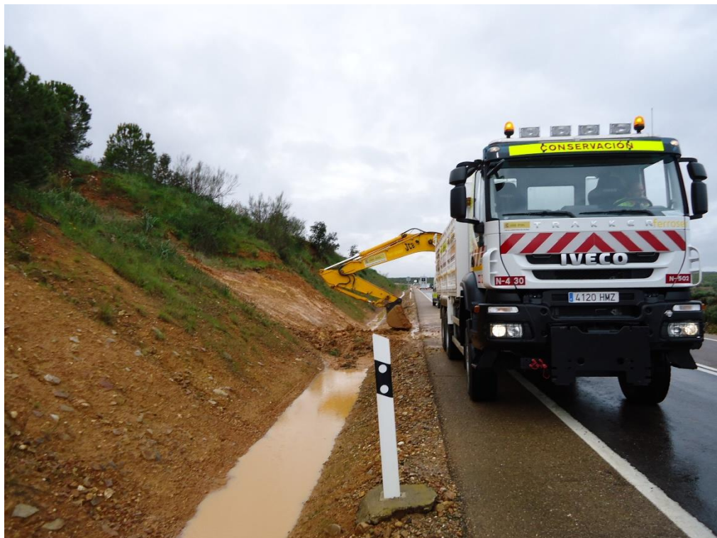
Retirada desprendimientos. N-430, km 112
