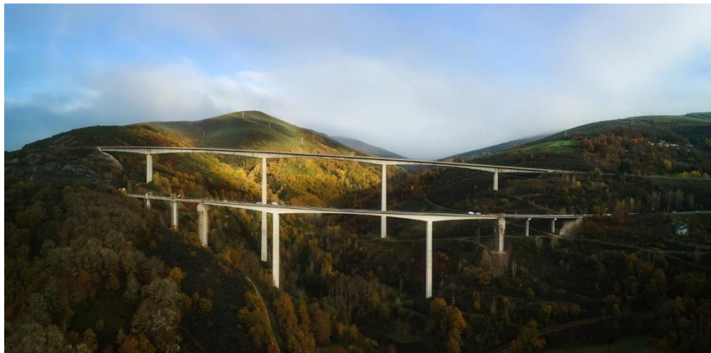
Viaductos Ruitelán y Samprón A-6 km 424
