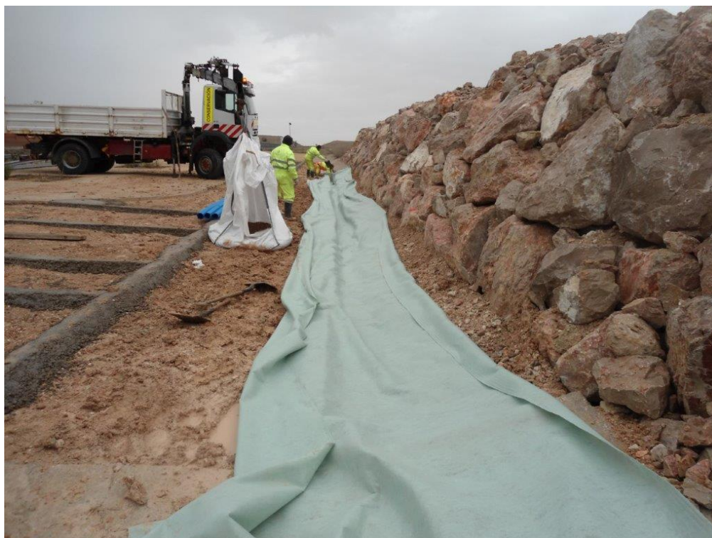
Colocación de geotextil de drenaje. A-40; km 250
