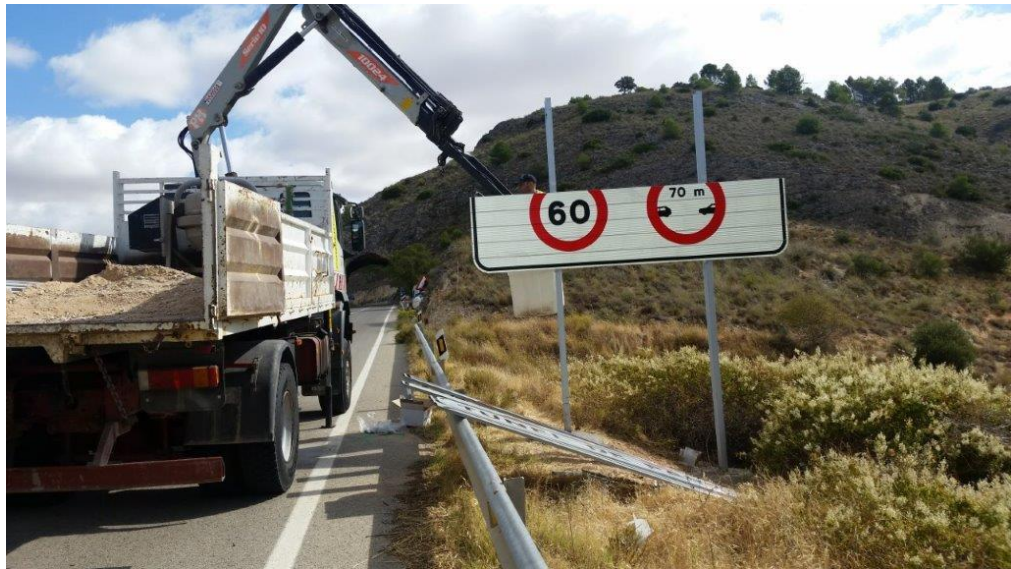
Instalación de cartel. N-400, km 111,200
