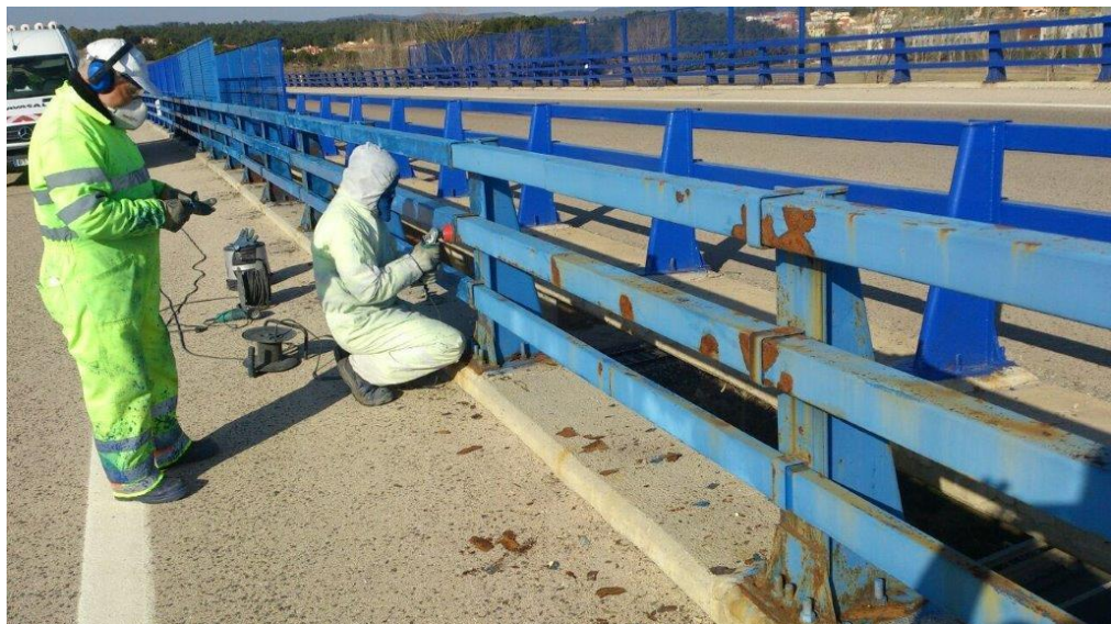
Trabajo de repintado de pretil. A-40, km 304,600, calzada derecha
