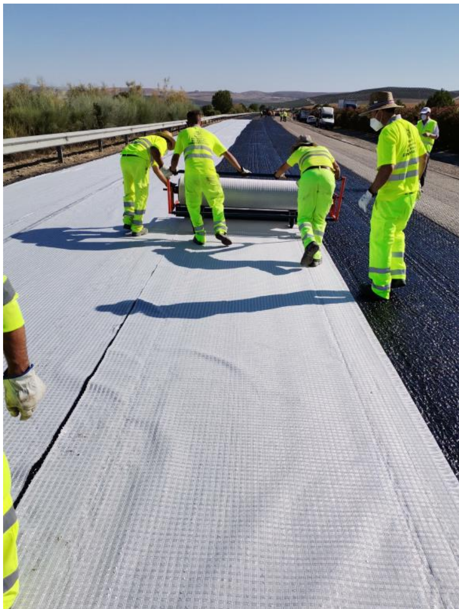
Colocación de Geomalla en la rehabilitación del firme. A-45. PK 7+100 MD
