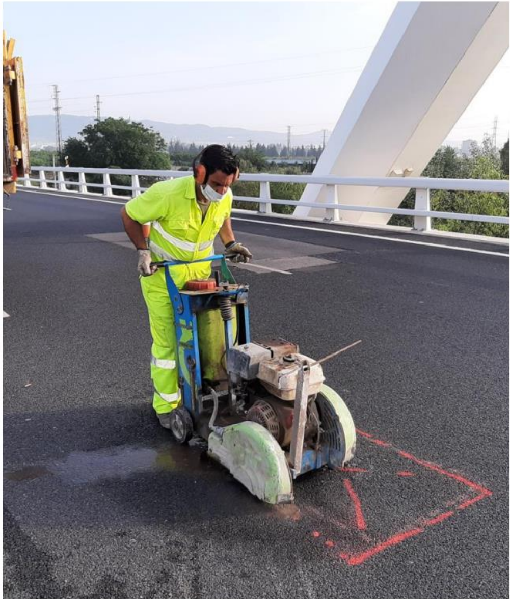
Reparación de deterioros del firme. CO-32. PK 4+350 MD
