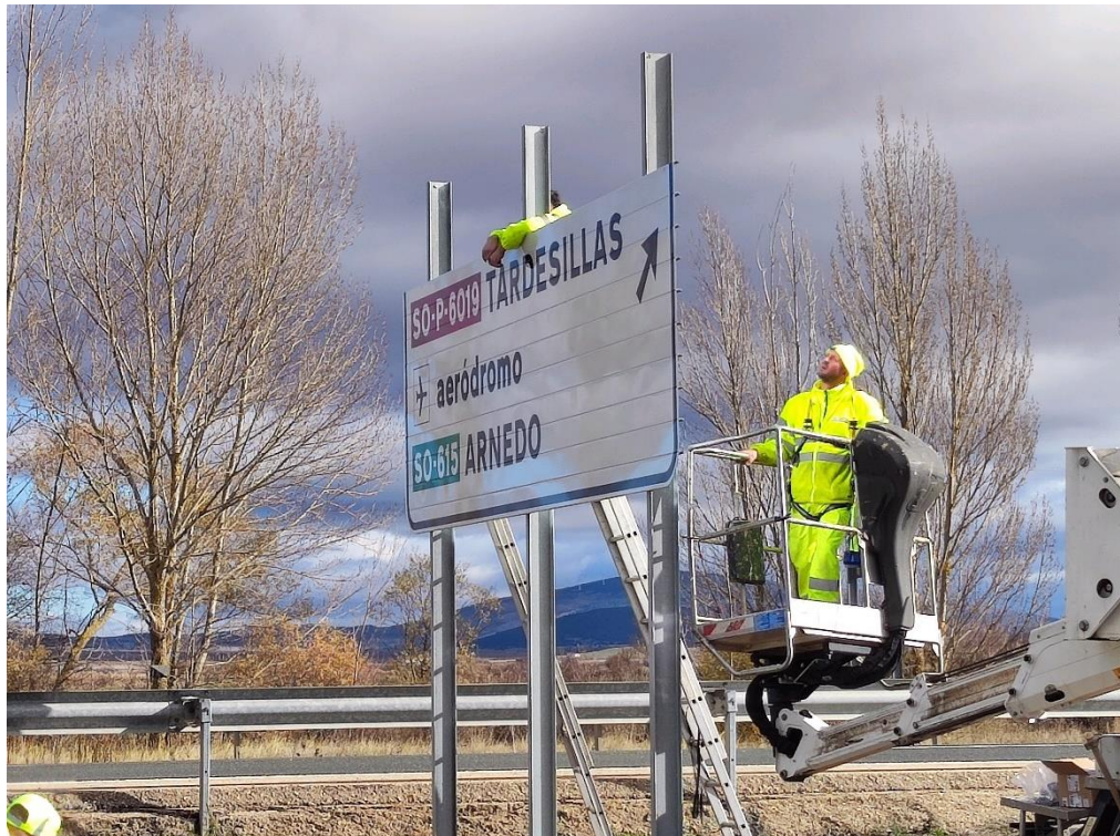
Colocación cartel de lamas N-111 p.k. 235+750
