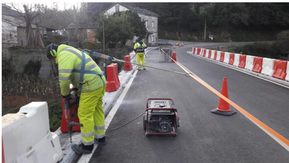
Instalación pretil Puente del Esquilo km 0,340 N-640A
