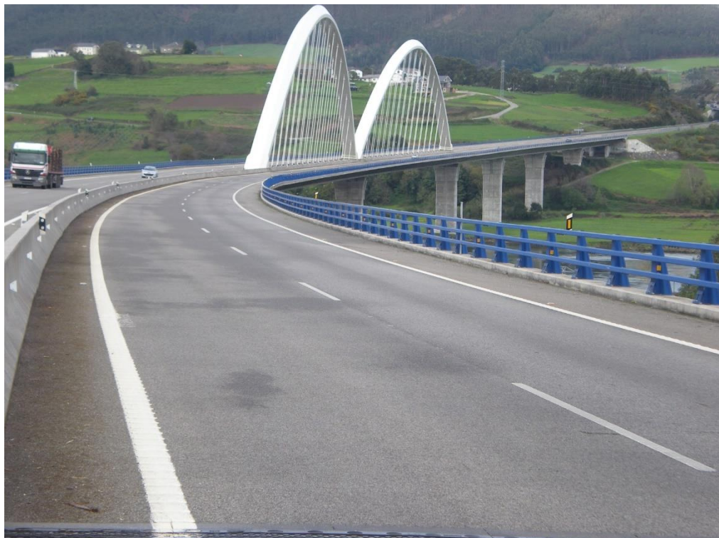
Viaductos ríos Anleo y Navia km 479,313, A-8
