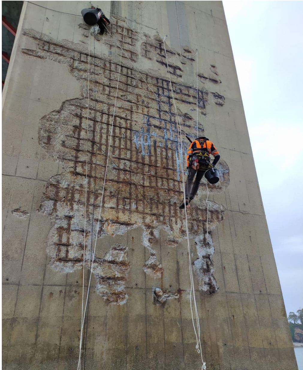
Reparación pilas Puente de Los Santos km 505,325 A-8
