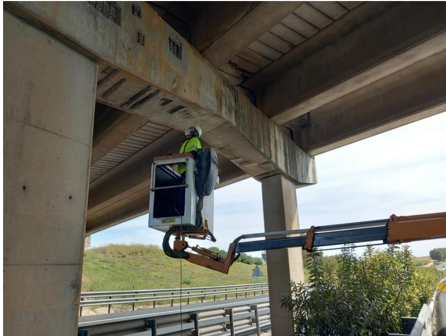
Rehabilitación de estructuras en el paso superior
