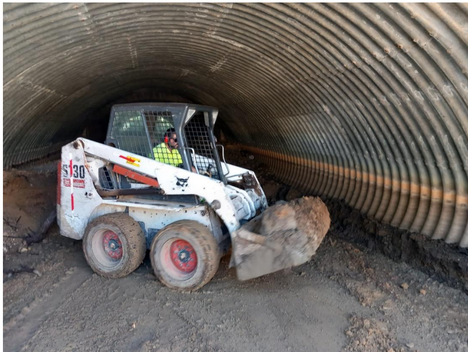
Limpieza de Obra de Drenaje Transversal
