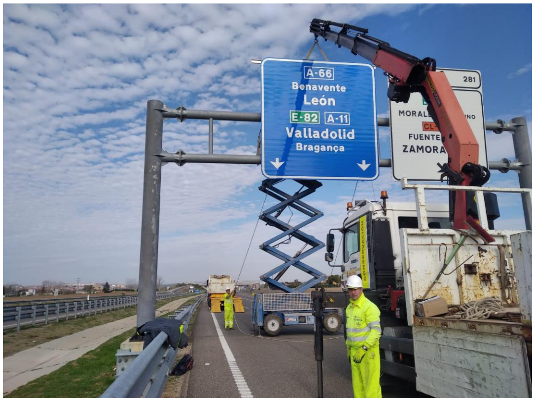
A-66 km 285,800 CI Colocación de cartel del pórtico
