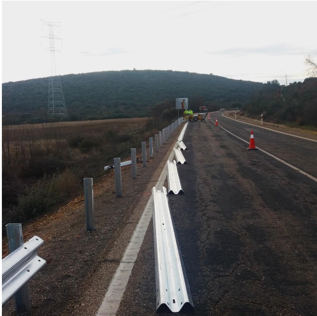
N-631 km 10,415 MD Colocación de barrera
