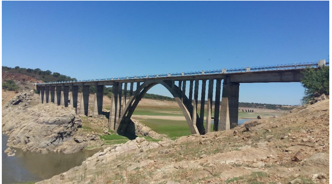
N-631 km 2,200 y 2,500 Puente la Estrella
