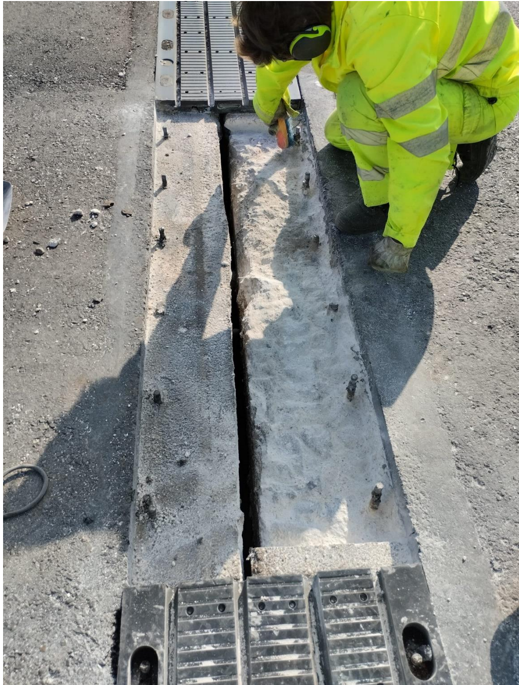
Reparación de junta de dilatación, A-5 km 109, margen derecha
