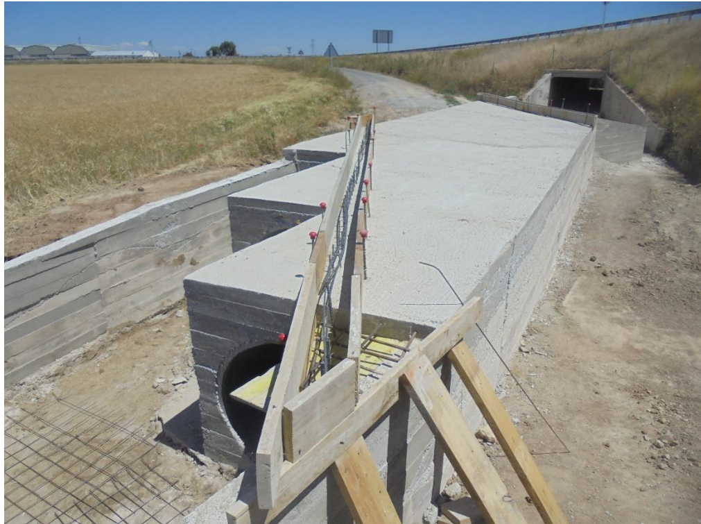
Construcción de obra de drenaje transversal y reposición de camino de servicio A-40, km 108,500
