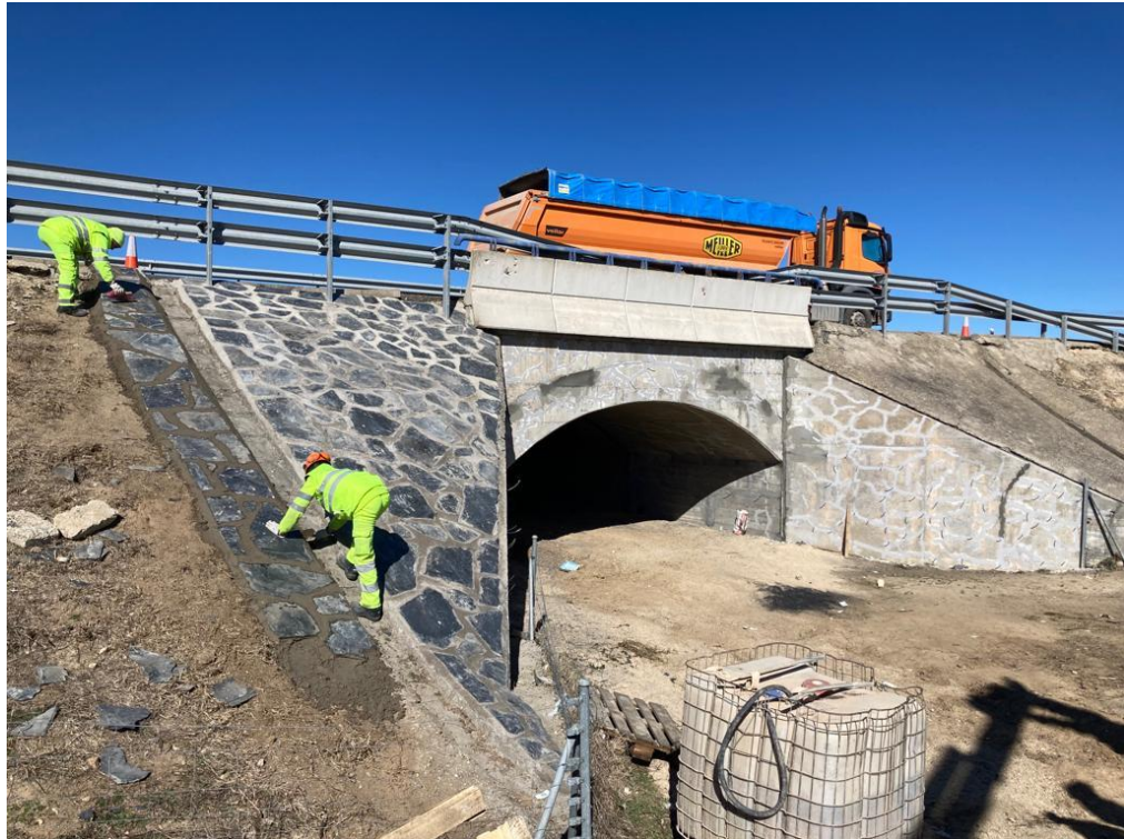
Rehabilitación-reconstrucción de encachados en pontón A-5, km 51,030, margen izquierda
