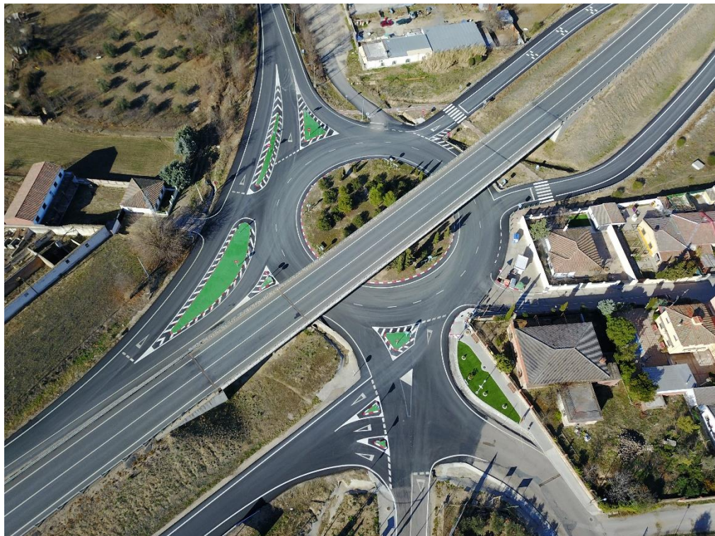
Refuerzo de Firme-Construcción Senda Peatonal N-403, km 52,300
