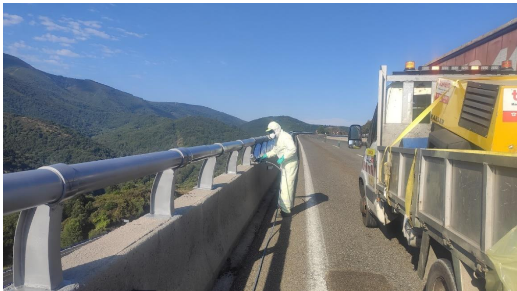
Repintado de barandillas A-6 km 424
