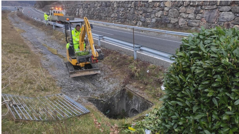
Limpieza de cunetas y arquetas A-6 km 449
