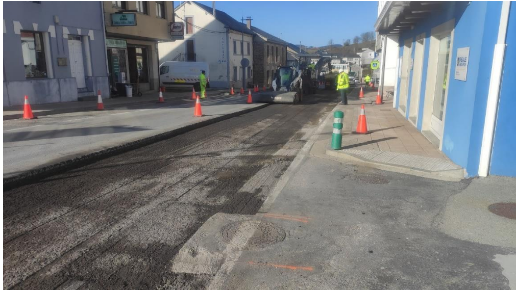
Fresado y reposición de aglomerado N-6 PK 432
