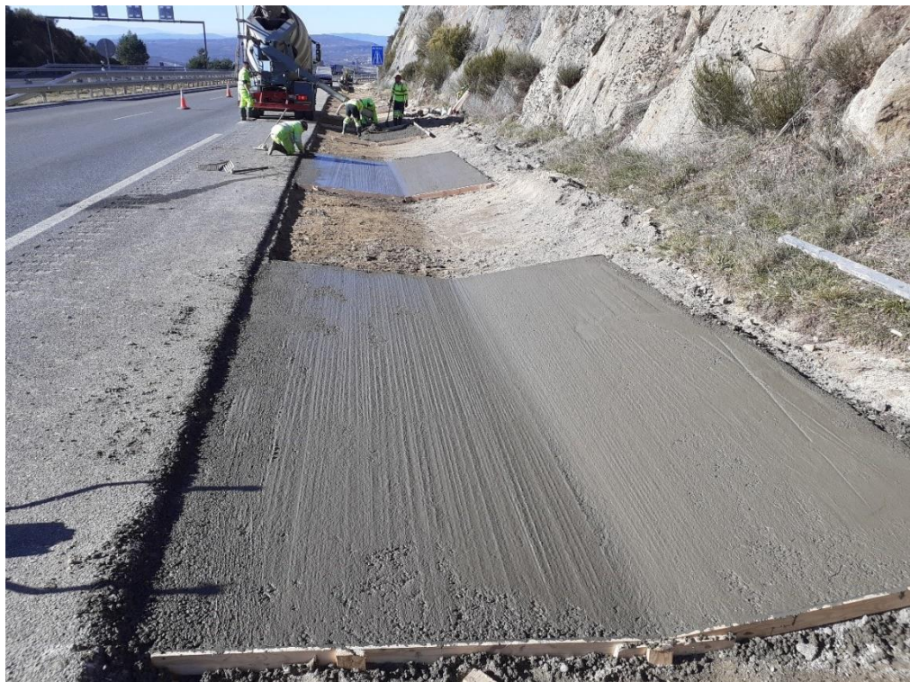
Reparación de cunetas A-52
