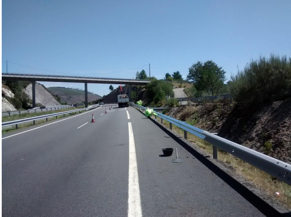
Reparación barrera de seguridad A-52
