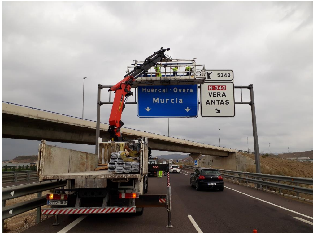
Sustitución de cartel en el km 534 de la A-7
