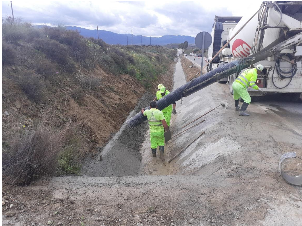
Construcción de cunetas en el km 523 de la N-340A
