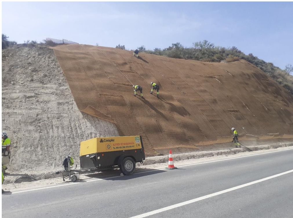
Colocación malla en el km 498,200 de la N-340A
