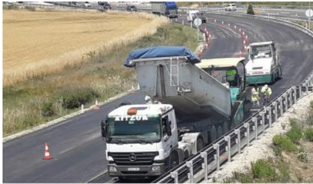
Refuerzo de firme (AP-1)
